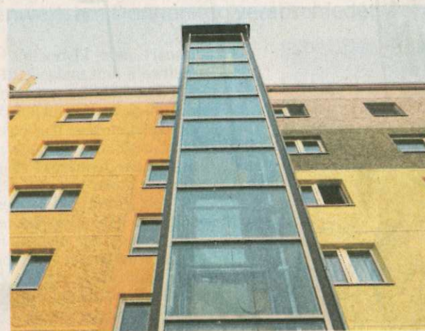
Sanierter Wohnblock in der Steinbeckstraße 1a-d in Gera-Langenberg. Zwei Aufzüge wurden eingebaut, Balkone erneuert und die Fassade farblich neu gestaltet.
